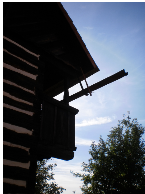
Obr. č.14 detail dřevěného okapu s hákem září 2011
