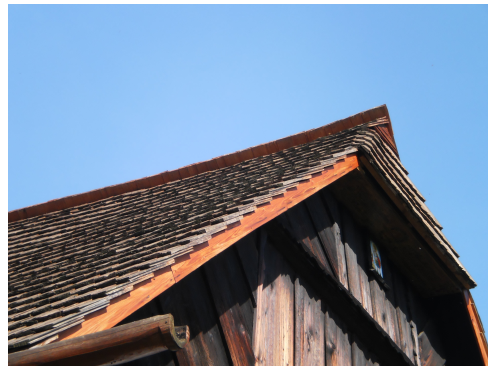
Obr. č.21 detail štítu a lomenice Šolcova statku září 2011
