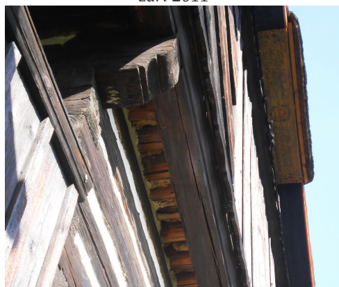
Obr. č.22 detail stropu horního patra a restaurované základy září 2011
