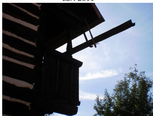
Obr. č.23 detail pavlače s okapem září 2011
